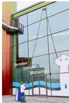
Homlokzattisztítás földről 20 méter magasságig
